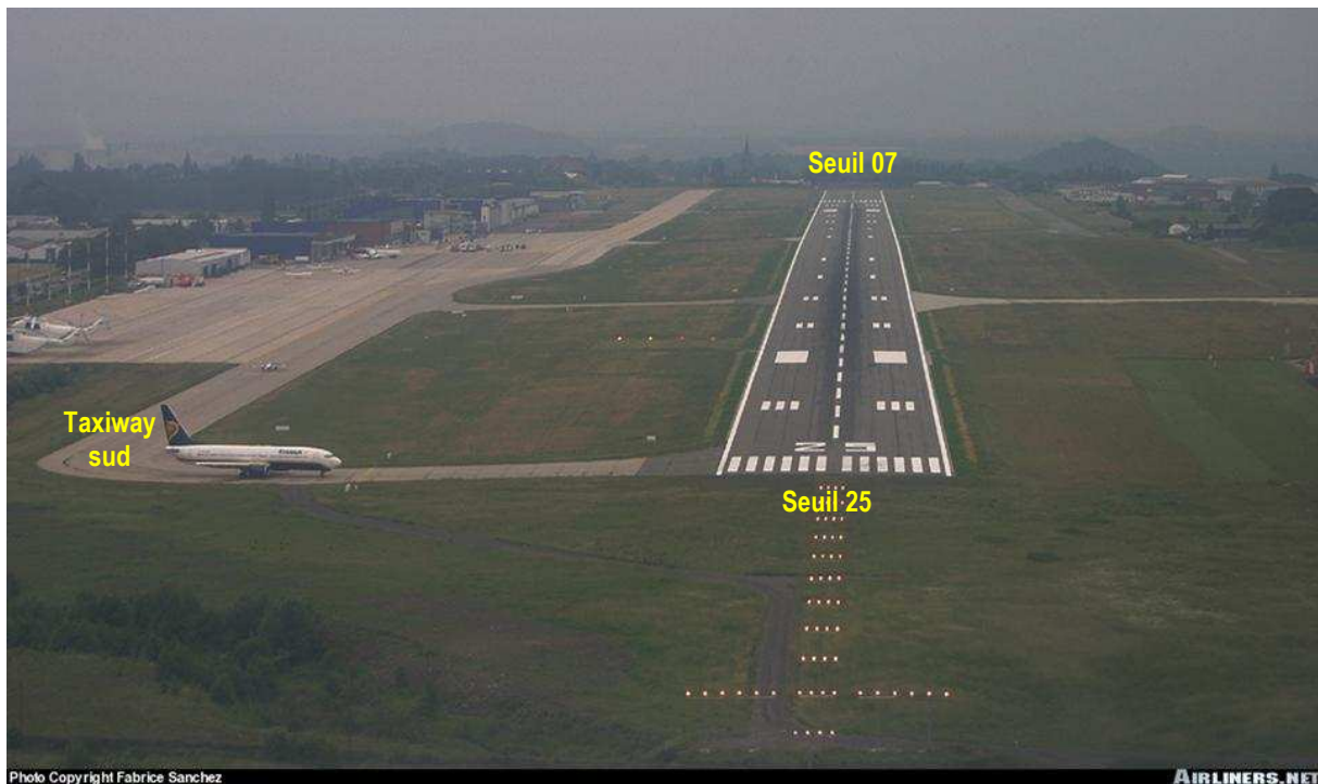
Figure 2 : vue de l'aéroport depuis le nord-est (Heppignies)
